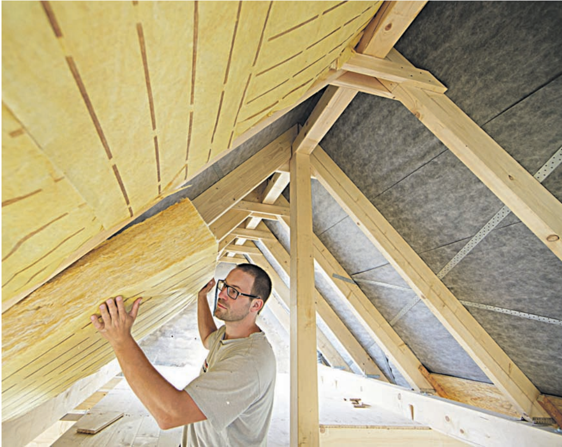
Energetische Sanierung zählt zu den Förderschwerpunkten.
